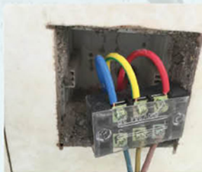
接线端子接线
