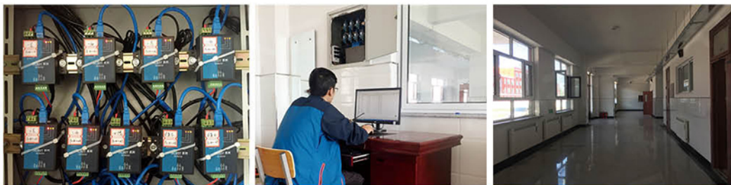
前郭县第二高级职业中学 教学楼金属膜电暖器集中控制调试
