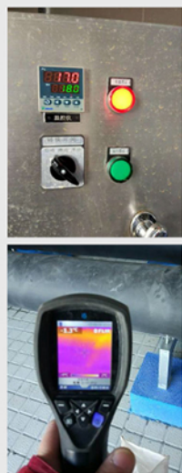
电伴热系统通电调试
