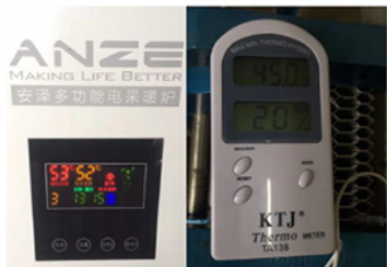
综合办公区热源：在原锅炉房中安装两台安泽72KW多功能电采暖炉，机房附属设备：板式换热器、锅炉循环泵、地热循环泵、软水器、自动补水定压装置，机房内连接设备管道均采用PPR热水管热熔连接或法兰连接。 Anze
