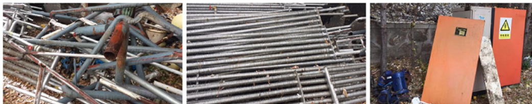
拆除原有管道、电暖器及设备
