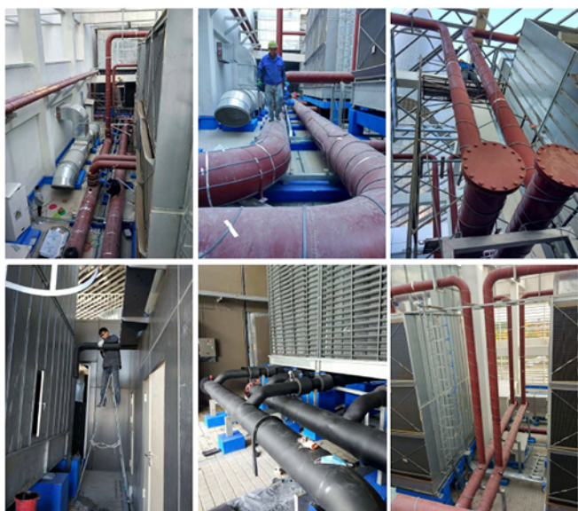
安泽电伴热系统现场施工图
