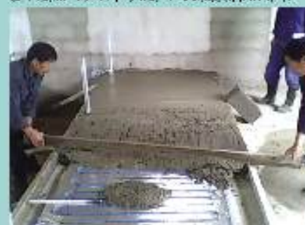
上图为在排好的发热电缆上铺上水泥，并抹平所铺设的地面。
