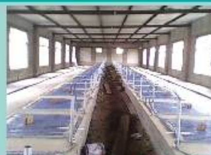
按图铺设的地面找平后，严格按照设计图线路铺设上发热电缆，上图为发热电缆安装后效果图。
