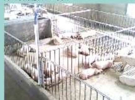
上图为安泽发热电缆铺设完工后，保育室的最终效果图。
