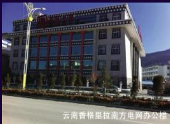
云南香格里拉南方电网办公楼
