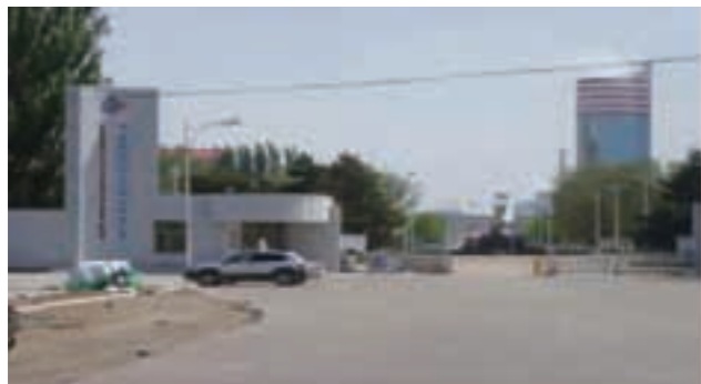
中海油天野化工管道电伴热工程
