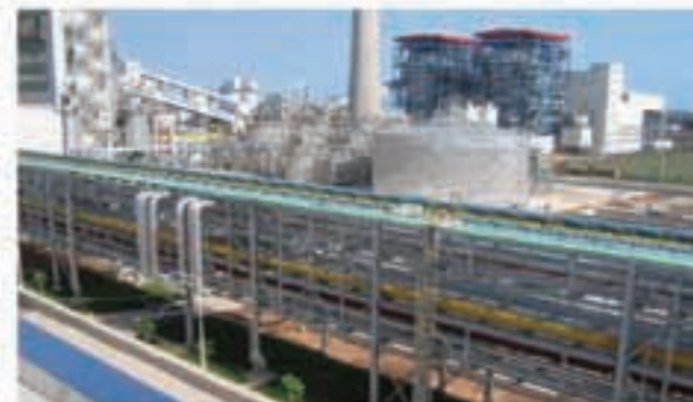
抚顺矿物局炼油厂工程
