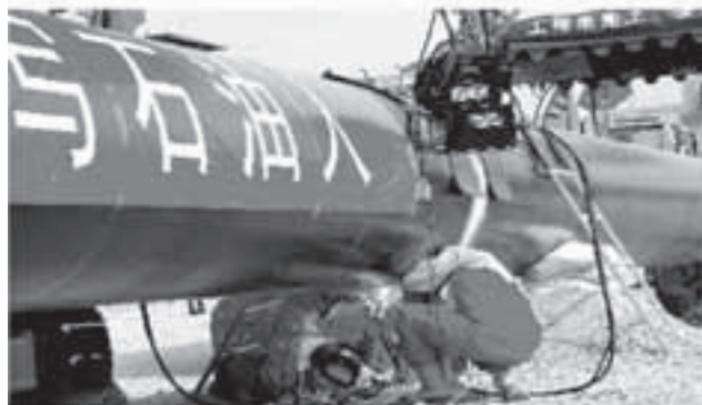
中国石油天然气管道分公司管道伴热工程
