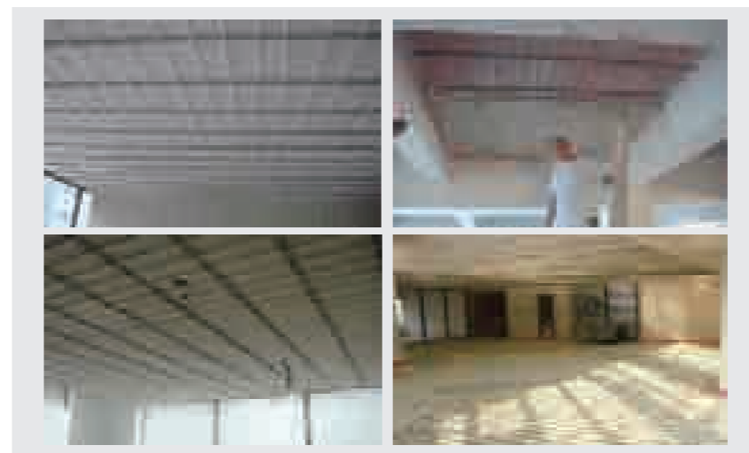
图三 辐射末端的安装
