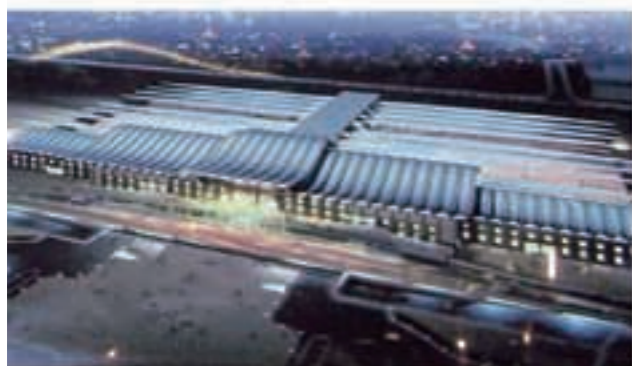
京沪高铁济南站屋面融雪工程
