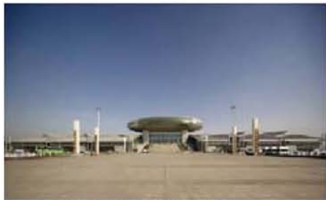
克拉玛依会展中心屋面及天沟融雪化冰工程 施工时间2012年，6000m 2
