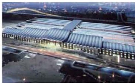
京沪高铁济南站屋面及天沟融雪化冰工程 施工时间2010年，10000m 2
