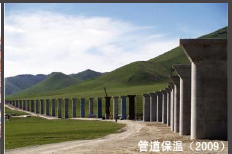
柴木铁路站台供水管道 20000m 2
