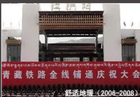
青藏铁路房建工程 130000m 2
