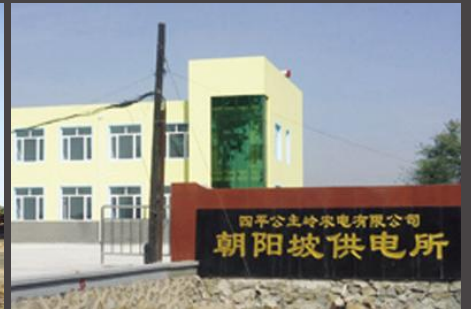
2011年四平市朝阳城供电所 15000m 2 地面舒适采暖
