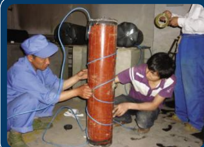
安装发热电缆
