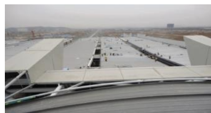
图 1 正在建设的西客站屋面
