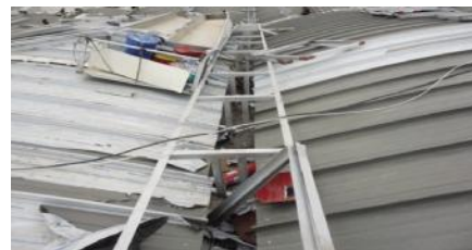
图 2 准备安装的西客站屋面天沟
