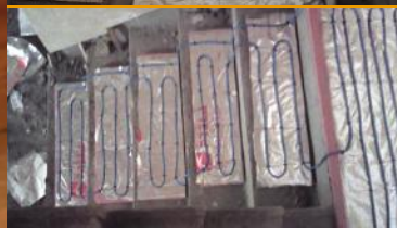
图 2 楼梯地暖铺设现场图
