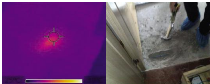
河南一客户卧室内门内 20 公分处用故障检测仪检测出断路点,刨开地面发现电缆外护套有明显损伤,电缆和保温板有明显的砸痕,为外重力使电缆受损造成。
