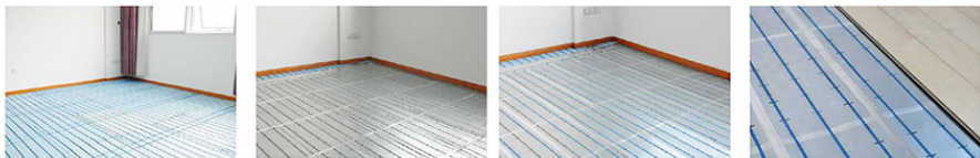
1 铺设安泽怡热阻燃干式采暖系统特制发热线
