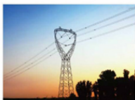
电力线路、塔架等特殊场所融雪化冰。
