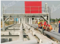
工作人员在进行加热电缆的安装
