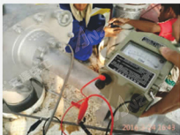
公司技术工程师正在进行加热电缆测量
