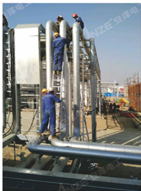
加热电缆的高空作业安装
