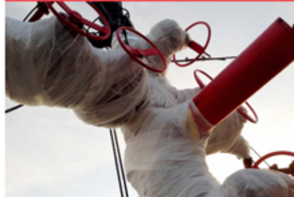
油井电伴热的外保温安装完毕
