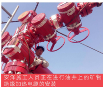
安泽矿物绝缘加热电缆在油井和管汇安装完毕
