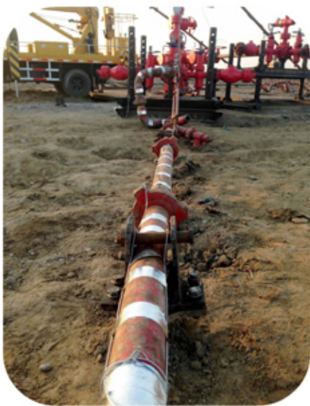
安泽施工人员正在进行油井上的矿物绝缘加热电缆的安装
