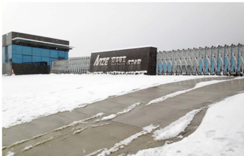
坡道融雪化冰系统的车轮区域效果(3小时开启)
