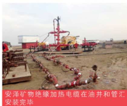
安泽施工人员正在进行油井上的矿物绝缘加热电缆的安装
